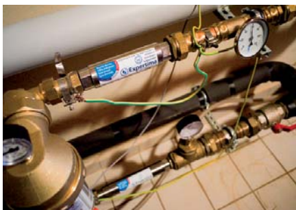
L'échangeur à plaques est protégé du tartre par des réacteurs d'Expertima. Dotés de disques spéciaux interchangeables, ils sont désormais disponibles avec un corps en inox 316 L.
