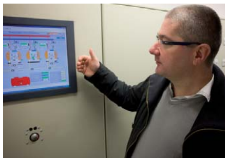
Didier Kasprzykowski, adjoint au chef de service technique du Centre hospitalier de Rouffach, responsable «gestion et maintenance», devant l'écran de contrôle de la gestion technique du site. Tous les points de mesure du site sont rattachés sur cet outil de contrôle. Il lance les alertes par texto et mail et fournit les rapports complets de fonctionnement des équipements.
